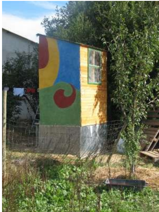
Coté lambris, en bas, accès aux deux bacs pour le déchargement
