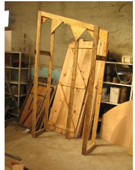
Montage de la structure bois en atelier
