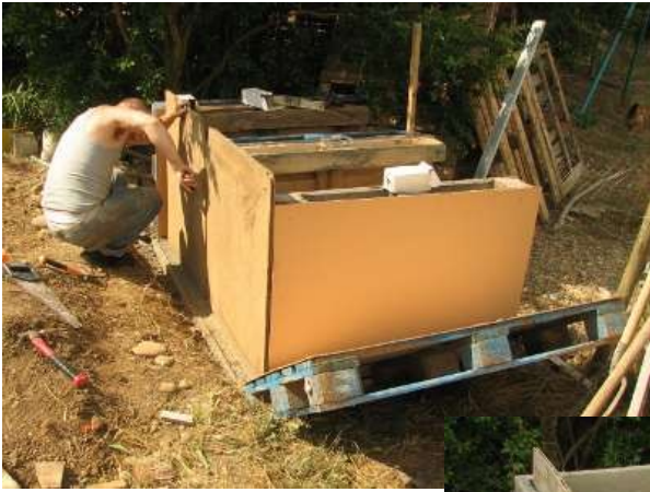
Coffrage avec des palettes et de l'isorel ou du médium 3 mm.
