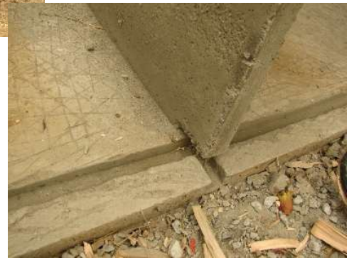
Rigole d'évacuation des liquides en excès
