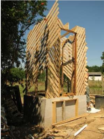
Structure de contreventement et support enduit en lambris déclassés
