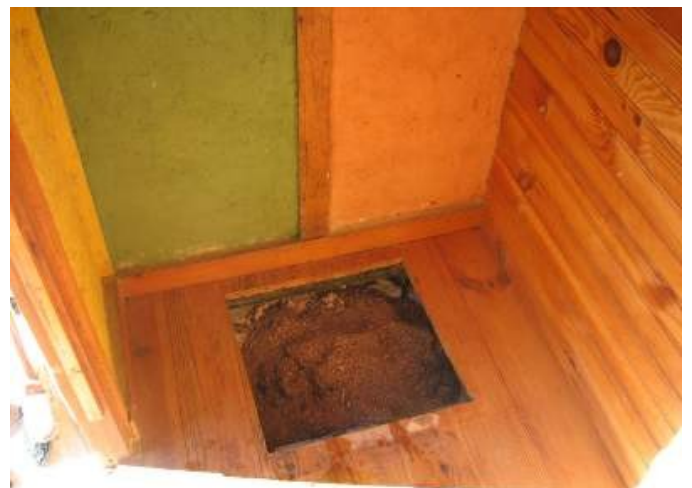
Emplacement des toilette n°1. Il y a deux trappes, on déplace les toilettes au dessus de l'une, puis, quand le bac est plein (8 mois), au dessus de l'autre.
