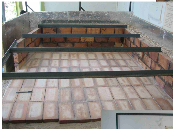
La sole en briques réfractaires et Les support de toit
