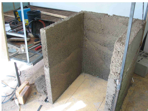
Coulage du béton isolant et décoffrage
