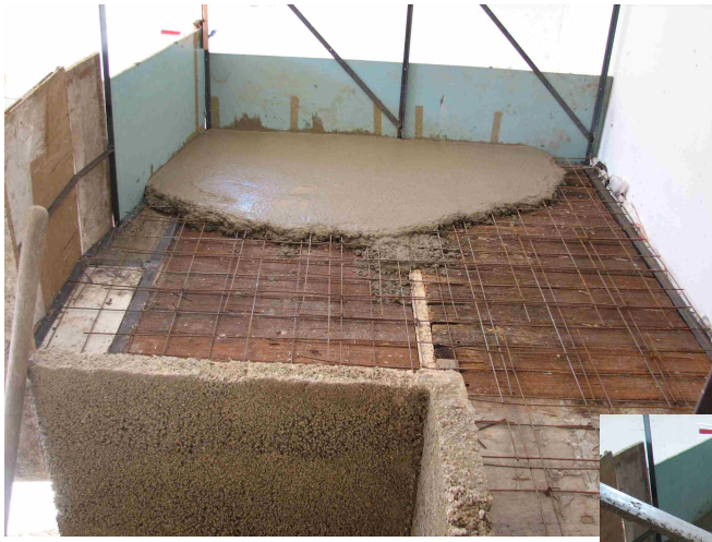
Ferrailage et coulage de la dalle porteuse (5 cm)
