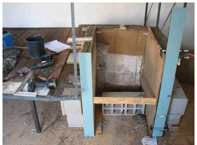
Coffrage à l'emplacement du foyer
