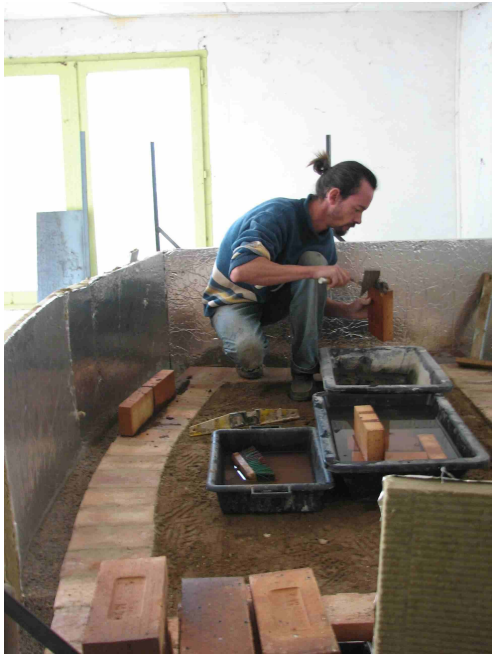
Montage du mur extérieur
