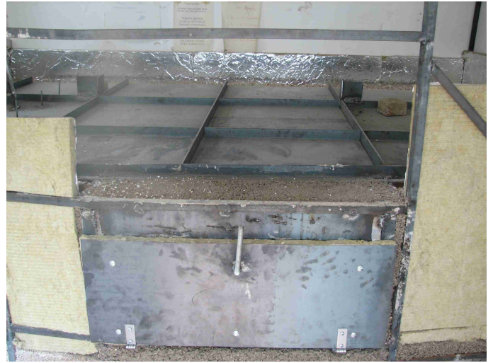
Mise en place de la porte isolée
