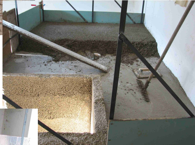
Pose de la protection extérieure et mise à niveau de la dalle
