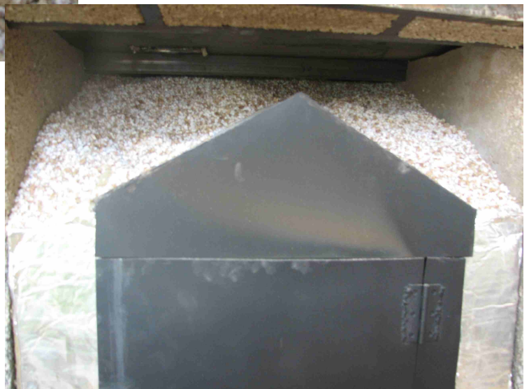
Mise en place et isolation du foyer à double combustion
