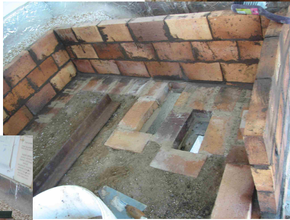
La sole en briques réfractaires et Les support de toit
