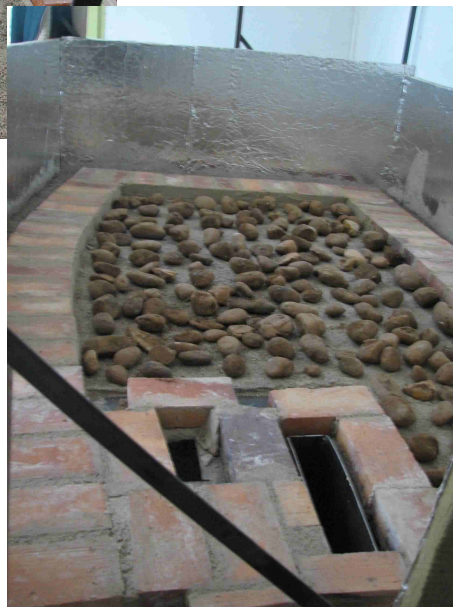
Galets pour l'accumulation thermique
