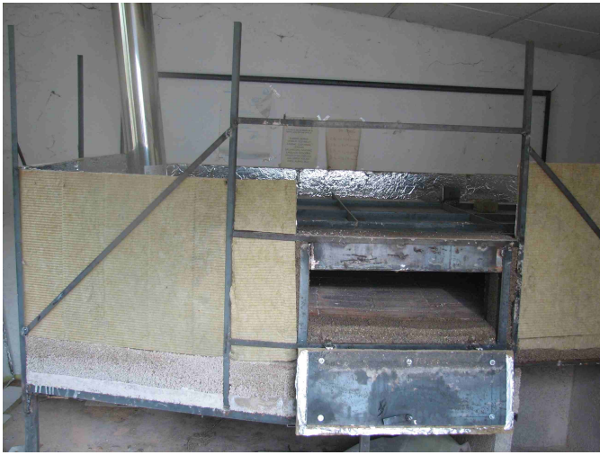
Mise en place de la porte isolée
