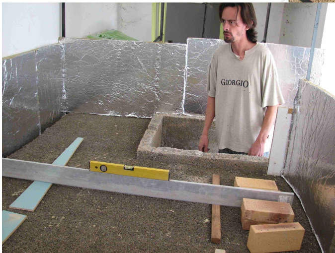
Pose de la protection extérieure et mise à niveau de la dalle
