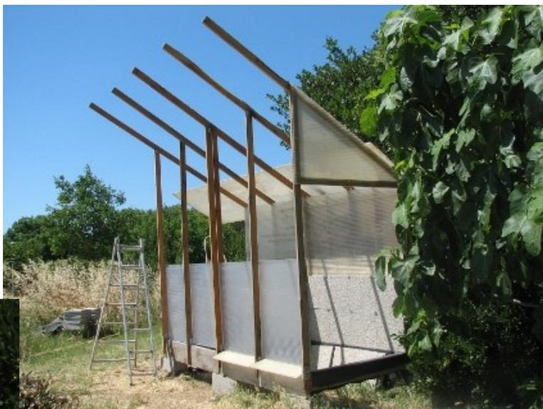
A l'extérieur de la face avant, un débord en polycarbonate permet de protéger le bois de l'écoulement d'eau de pluie.
