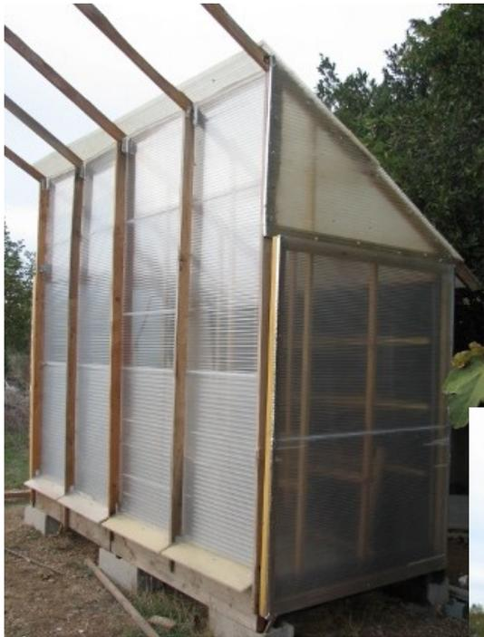
Les portes sont placées et les espaces entre plaques bouchés au silicone de l'intérieur. Au sol une plaque en pente pour l'évacuation de l'eau, on utilise un matériau isolant (ici du polycarbonate alvéolé).
