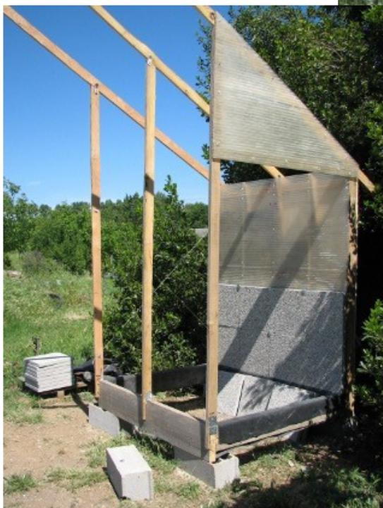
Les pièces de bois sont protégées par une bâche EPDM (caoutchouc synthétique). A l'intérieur de la face nord : une couche de polycarbonate (toute matière imperméable, imputrescible et rigide est utilisable), puis la masse d'accumulation thermique, ici des dalles de béton.
